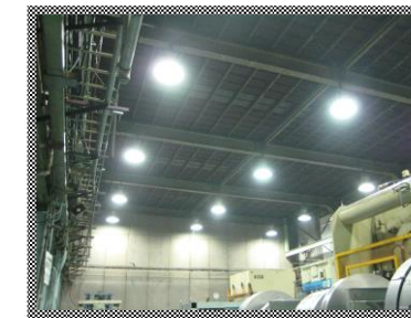
工場内、水銀灯を無電極灯へ交換 400w×15灯→200w×15灯 設置後100ヶ月の削減電力量72,000kWh 原油換算 約18,000ℓ削減
