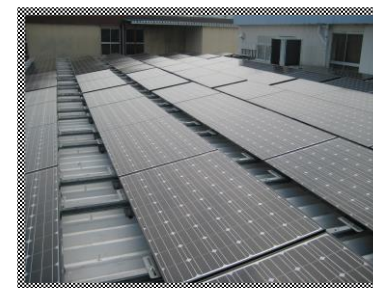
太陽光発電パネルを工場の屋根に設置 設置後87ヶ月間の総発電電力量567,000kWh 原油換算 約142,000ℓ削減
